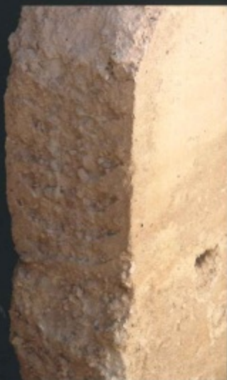
Tapia calicostrada seccionada. Castillo de Castalla.
