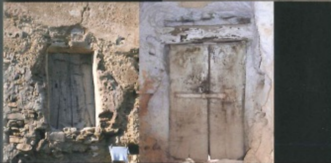
Vista exterior e interior del vano de acceso actual, antes de las obras de 2006. Última ubicación del portón.
