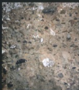
Tapia hormigonada (ligeramente disgregada). Torre de Maçanes.
