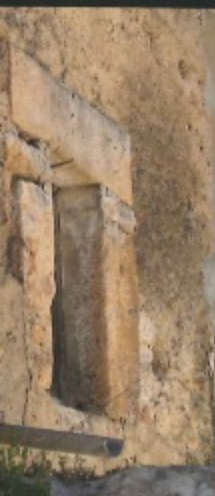
Torre de Godelleta. Detalle del vano de entrada.
